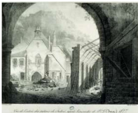
Vue de l'entrée des salins après l'incendie de 1825 2
